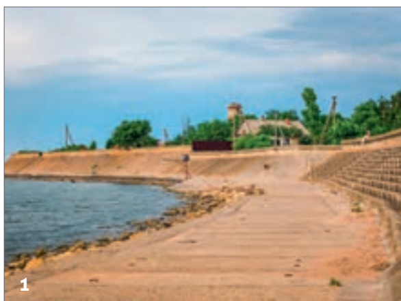
Берегоукрепительные сооружения: 1 — непроницаемые волноотбойные конструкции города Приморско-Ахтарска, 2 — волногасящие конструкции набережной олимпийских объектов города Сочи, 3 — искусственные пляжи и волноотбойные стенки на участке железной дороги Туапсе — Adler
