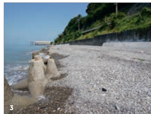
Берегоукрепительные сооружения: 1 — непроницаемые волноотбойные конструкции города Приморско-Ахтарска, 2 — волногасящие конструкции набережной олимпийских объектов города Сочи, 3 — искусственные пляжи и волноотбойные стенки на участке железной дороги Туапсе — Adler
