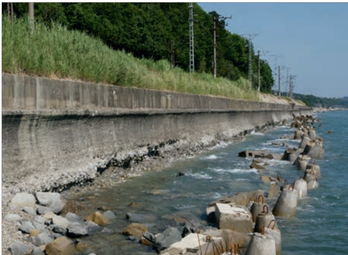
Деформация берегозащитных конструкций на участке прибрежной железной дороги Туапсе — Адлер — отсутствие пляжевой полосы в основании волноотбойной стенки
