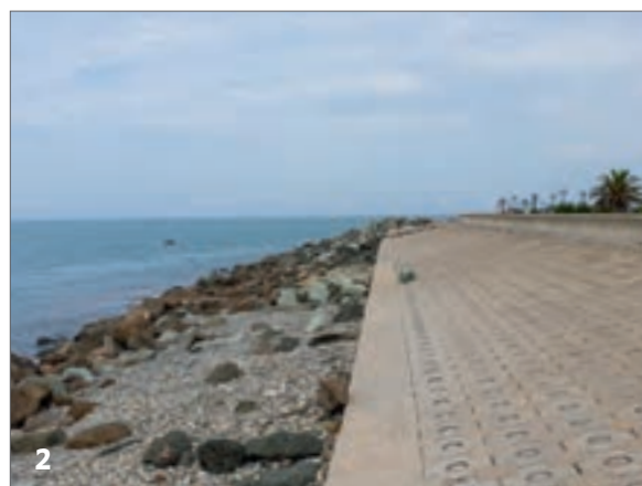
Берегоукрепительные сооружения: 1 — непроницаемые волноотбойные конструкции города Приморско-Ахтарска, 2 — волногасящие конструкции набережной олимпийских объектов города Сочи, 3 — искусственные пляжи и волноотбойные стенки на участке железной дороги Туапсе — Adler
