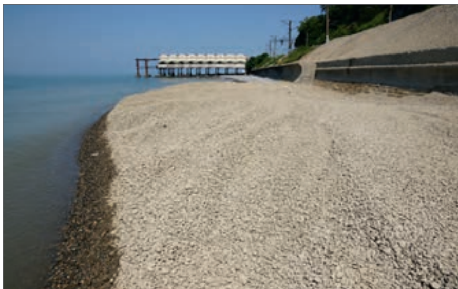
Защитная волногасящая пляжевая полоса на участке берегоукрепительных сооружений железной дороги Туапсе — Адлер
