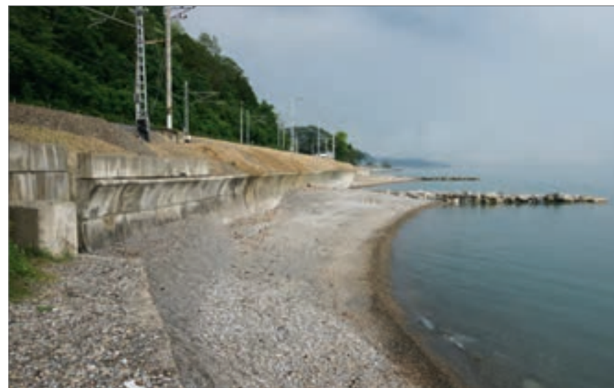
Защитная волногасящая пляжевая полоса на участке берегоукрепительных сооружений железной дороги Туапсе — Адлер
