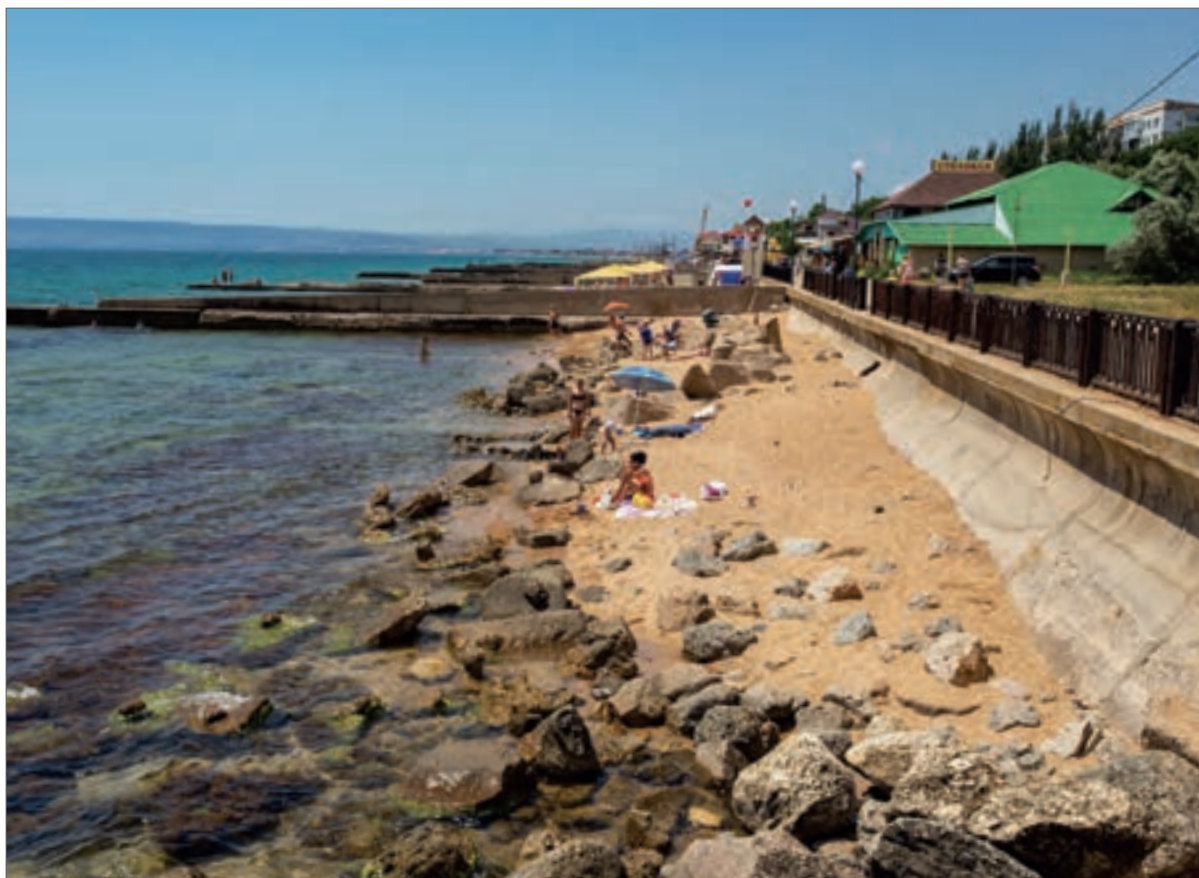
Сборные железобетонные конструкции и каменные наброски в сочетании с наносоудерживающими (буны) сооружениями, поселок Приморский, Крымский полуостров
